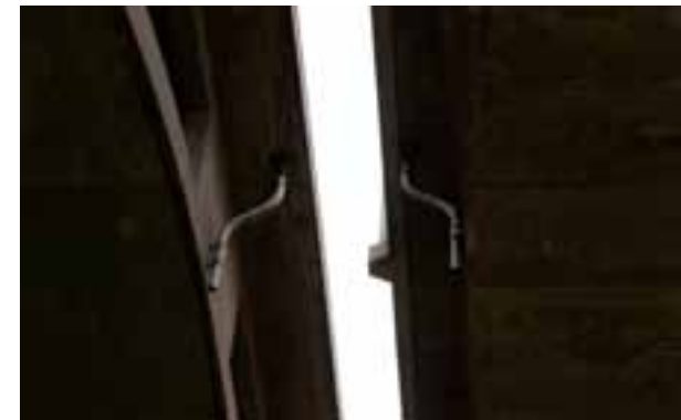
Figur 36 Båda bilderna visar dagvattenledningarna på nuvarande broar sedda från marknivå. Dagvattnet släpps idag orenat till sundet. De tjocka, grå rören på bilden ovan är fjärrvärmeledningar.
