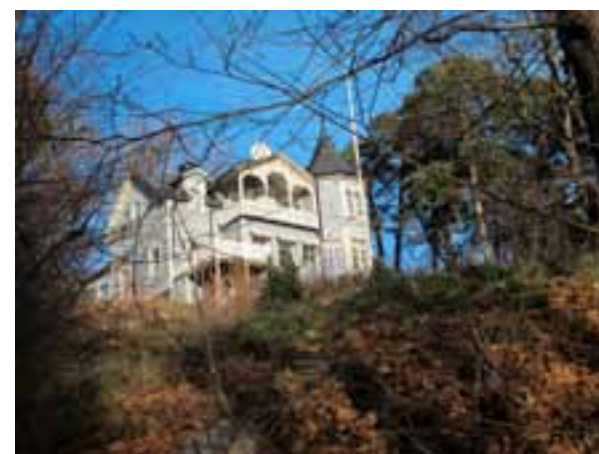
Figur 27 En av de två sommarvillor från 1800-talets slut som kommer att rivas i och med bygget av den nya bron.
