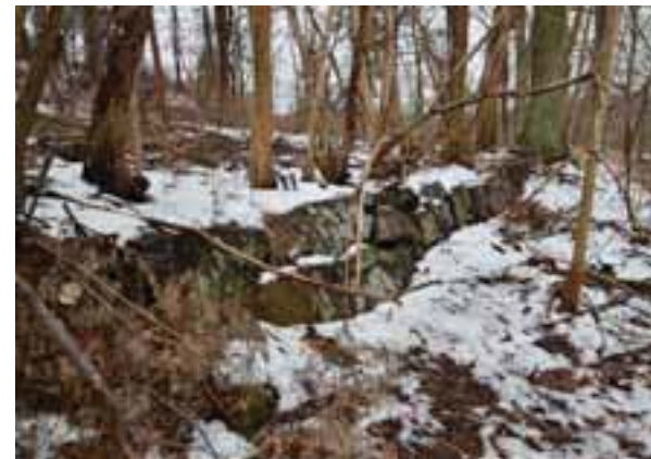
Figur 26 Rester av kallmur (kvarnrännan).
