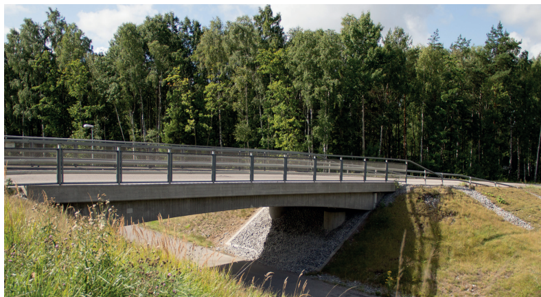
Figur 4. Gång- och cykelportar föreslås utformas på liknande sätt som befintlig port under ramp i trafikplatsen.
