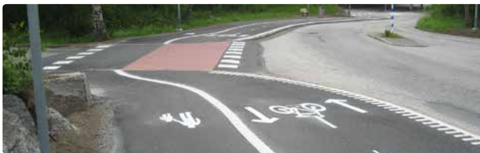
Den lösning som används idag med indragning av cykelbanan medför tvåa kurvor och otydligheter kring vem som har företräde.
