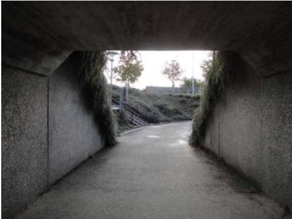
Bild 64: Gång och cykeltunnel i anslutning till stationen
