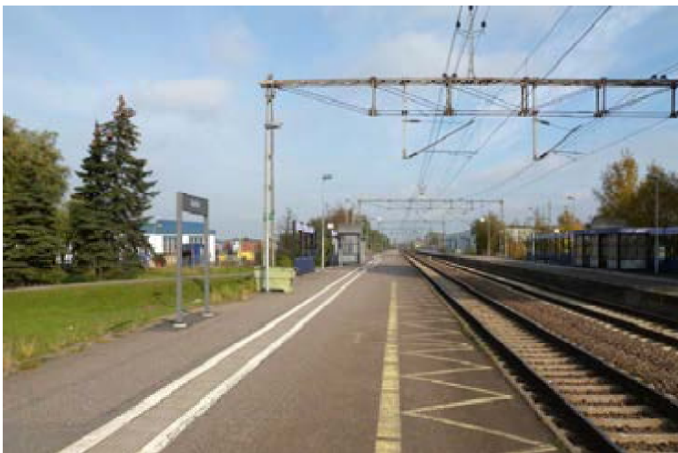
Bild 28: Burlövs station idag, sett mot norr
