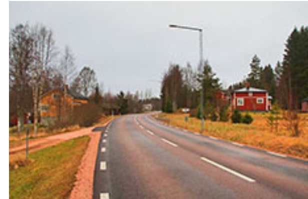
Figur 2.1.1. Befintlig väg vid Yttermalung.
