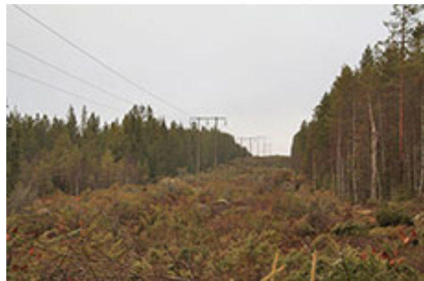
Figur 4.7.5. Kraftledningen vid korsningen av E16 norr om Almasjön.
