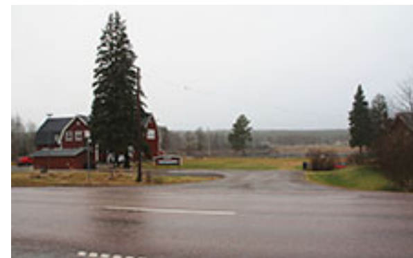
Figur 6.3.2. Utblick mot älven vid gamla skolan i Östra Utsjö. Här ansluter korridor A till befintlig väg.
