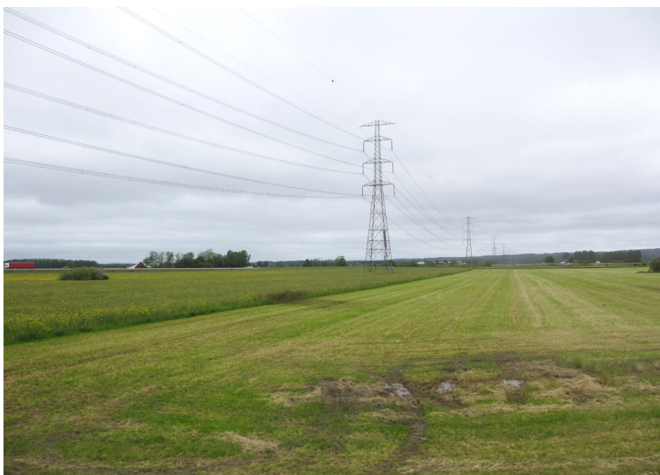
Det flacka slättlandskapet med inslag av storskalig infrastruktur. Foto WSP
